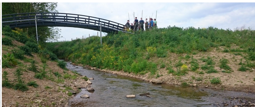
Monding Sint Jansbeek bij Boxmeer: de stuw en drempel vormden een harde barrière voor vissen (l). Die constructies zijn verwijderd en op de plek van de stuw is een nieuw houten voetgangersbruggetje gebouwd; de beek is sindsdien weer vrij optrekbaar voor vis (r).
