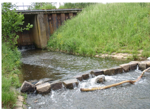
Monding Sint Jansbeek bij Boxmeer: de stuw en drempel vormden een harde barrière voor vissen (l). Die constructies zijn verwijderd en op de plek van de stuw is een nieuw houten voetgangersbruggetje gebouwd; de beek is sindsdien weer vrij optrekbaar voor vis (r).
